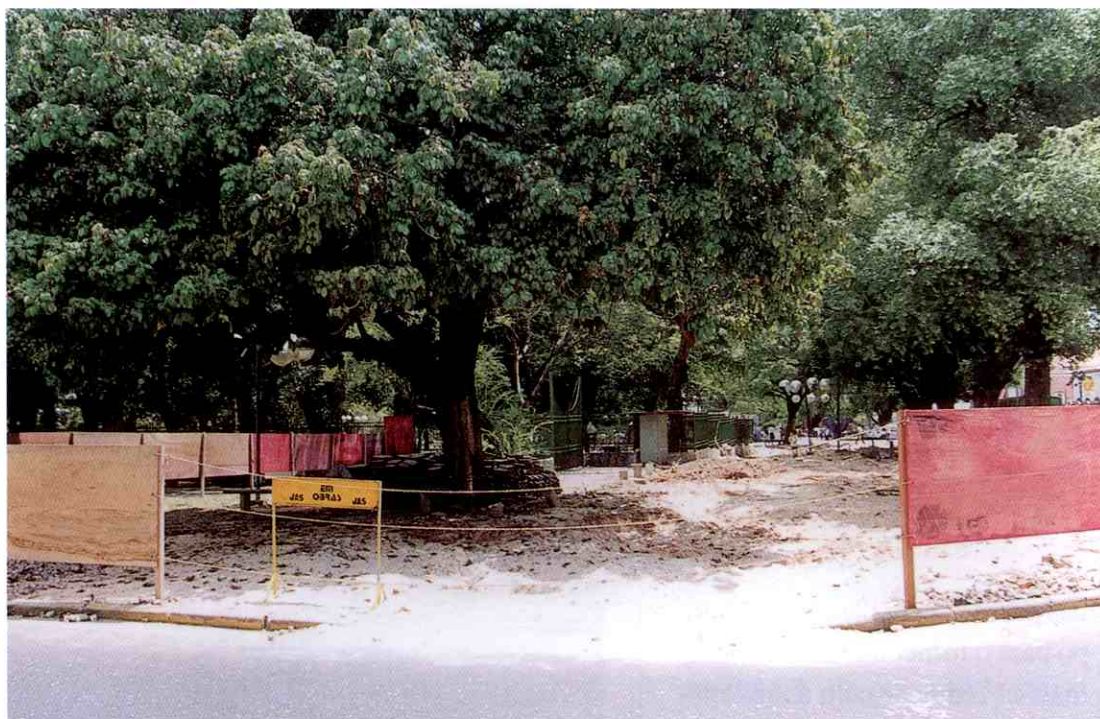
Obras na Praça Saraiva para melhorar o tráfego do centro
